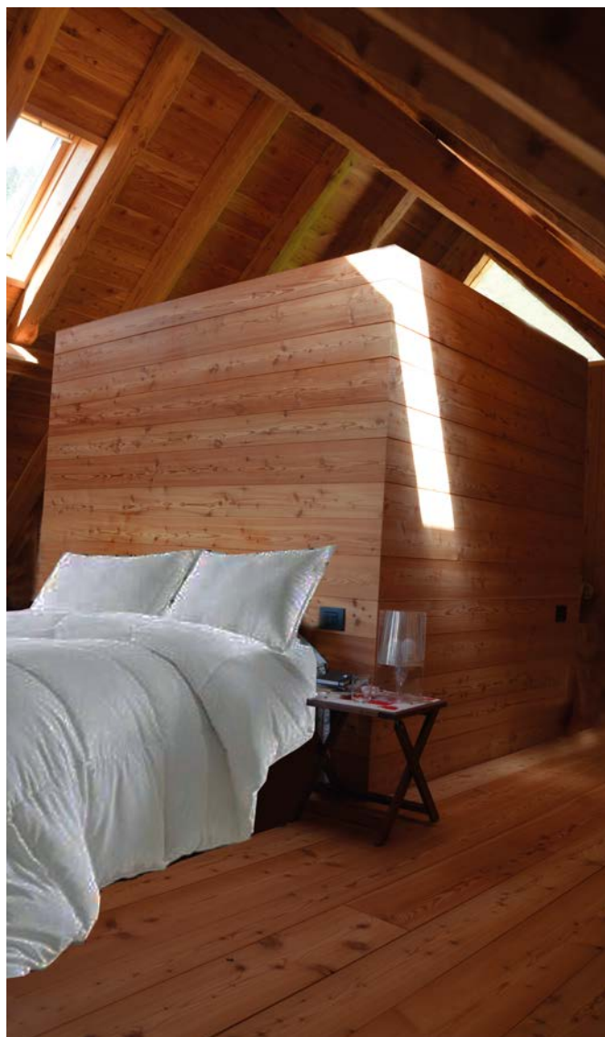
6. Primo piano: inserimento di una scatola lignea per ospitare il bagno e consentire la percezione unica del tetto.
