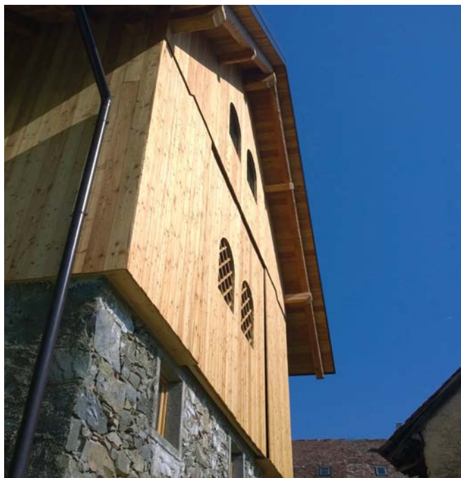
8. Prospetto ovest: sistema di scuri chiuso a dare continuità al tavolato.
